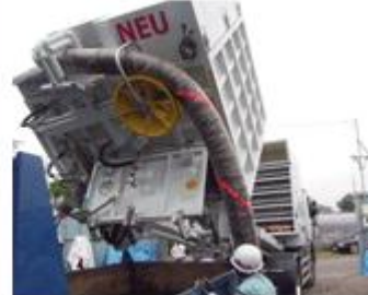
●掘削土砂積替状況
