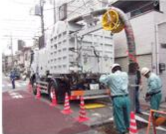
●吸引掘削状況(1)
